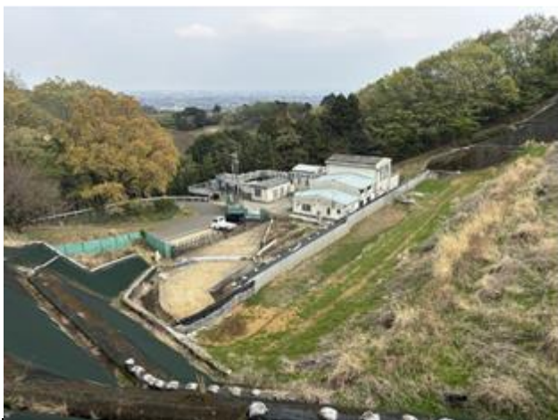
浸出水処理施設
