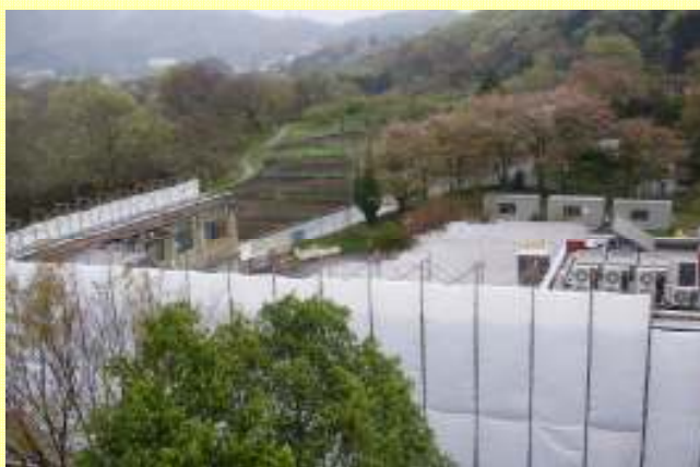
現在、し尿処理施設の解体を行っています。
