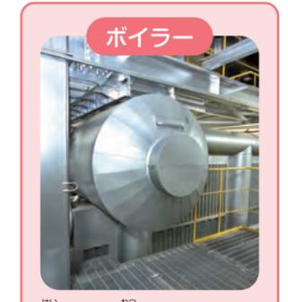
排ガスの熱でボイラーの水をあたため、蒸気をつくります。
