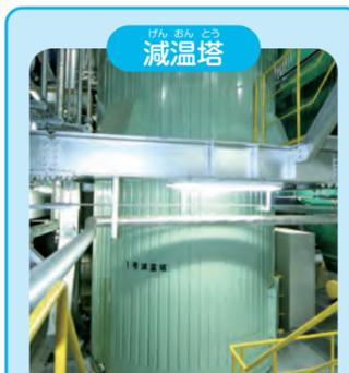
焼却炉から発生した排ガスの温度を下げます。
