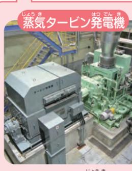
ボイラーでつくった蒸気で、タービン発電機を回転させて最大3,820kWの電気をつくります。
