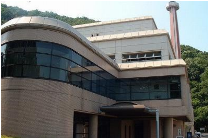
90t/日焼却施設
