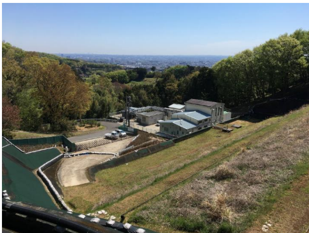
浸出水処理施設
