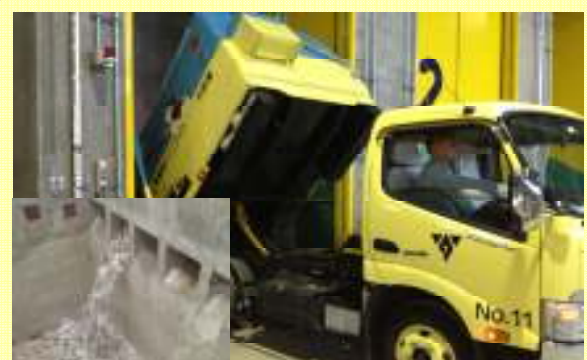
可燃ごみがピットへ搬入されています。
